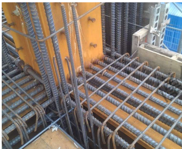
SRC 施工照片
